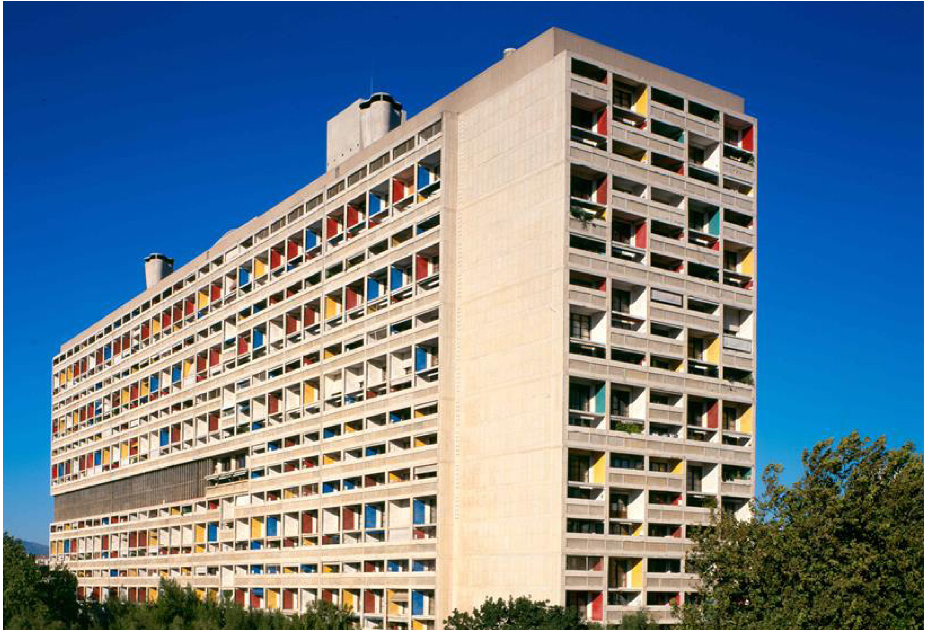
Unité d'Habitation Marseille, France 1945
